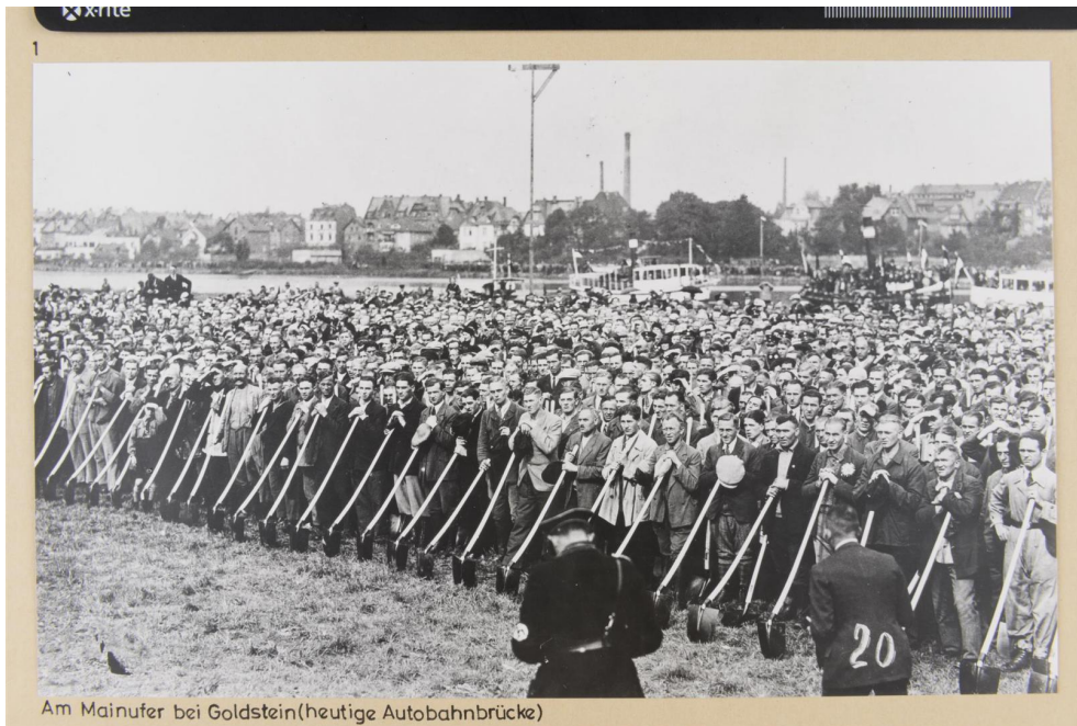
Am Mainufer bei Goldstein (heutige Autobahnbrücke)
