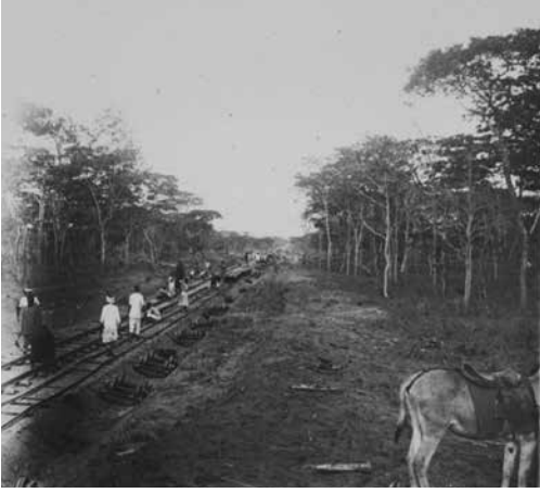
Arbeiten an der Spitze der Zentralbahn in Deutsch-Ostafrika im Tabora.
